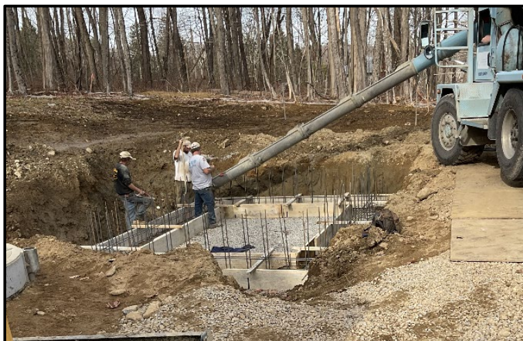
Foundation Footings Concrete Pour
